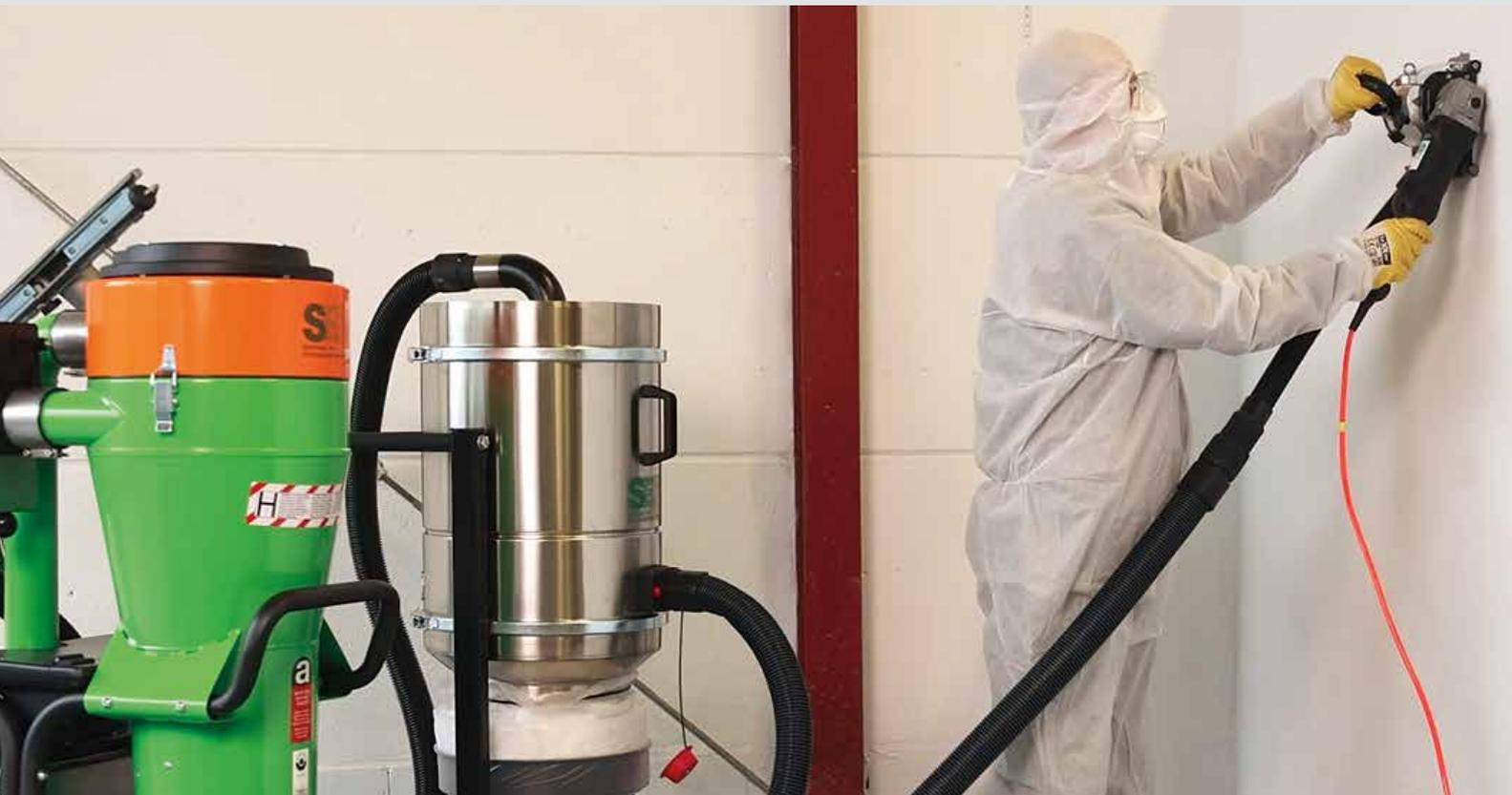
Der konventionelle Ausbau von Asbest oder asbesthaltigen Produkte ist sehr aufwendig und komplex. Unsere Verfahren ermöglichen eine emissionsarme Sanierung mit einem kleinen platzsparenden Maschinenpark, sowie eine geringe Stromleistungsaufnahme. Unser Bestreben ist es konstruktiv, lösungsorientiert und angstbefreit mit dem Thema Asbest umzugehen
