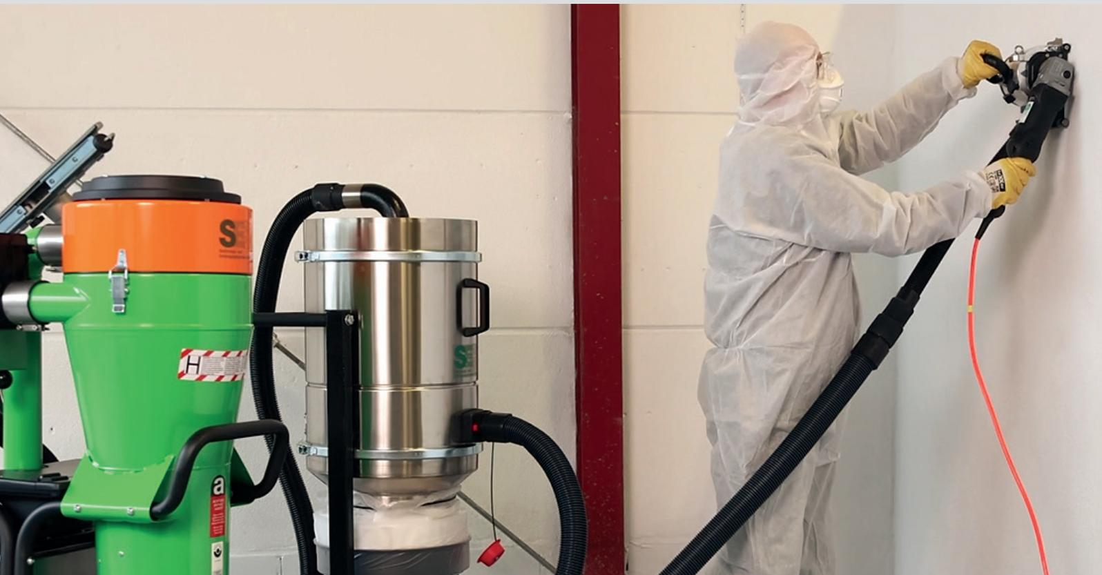
Der konventionelle Ausbau von Asbest oder asbesthaltigen Produkte ist sehr aufwendig und komplex. Unsere Verfahren ermöglichen eine emissionsarme Sanierung mit einem kleinen platzsparenden Maschinen-
