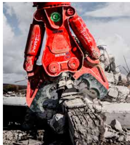
RCC30 Rotar Betonbrecher im kraftvollen Einsatz
